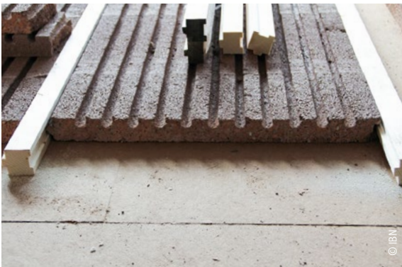
Fußbodenheizungssystem für Trockenbau: In die Tonelemente werden Heizleitungen eingelegt, auf den Hölzern dazwischen das Parkett fixiert
