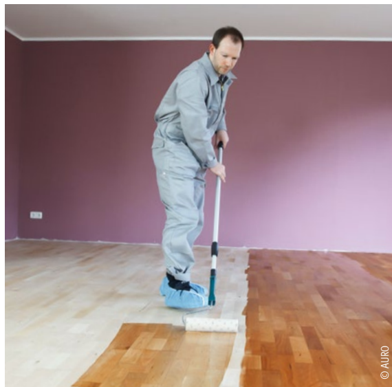
Der erste, satte Ölauftrag erfolgt oft mit der Walze
