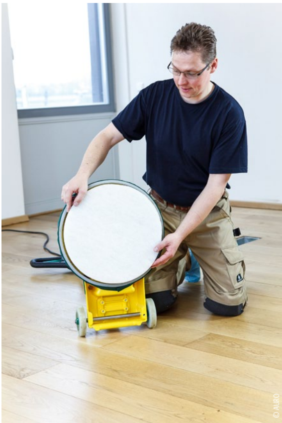
Nach dem Ölen wird poliert, am Ende mit einem weißen Pad
