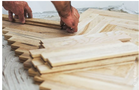
Fachgerechte Verlegung von Parkett
