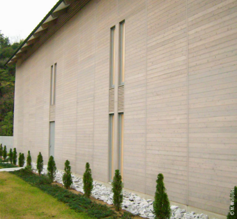
Graue Holzlasur auf Gebäudeverschalung
