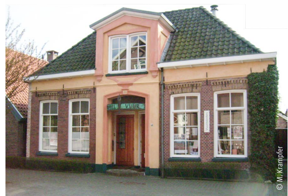
Der rote, regionale Backstein harmoniert mit ockerfarbenen Silikatfarben und Ölfarbe für die Fenster
