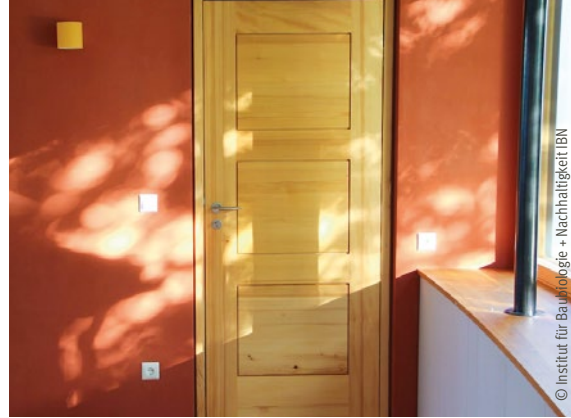
Innentür aus Vollholz (Tanne) in Rahmenbauweise
