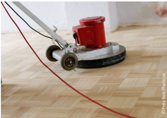
Geschliffen wird in bis zu drei Arbeitsgängen
