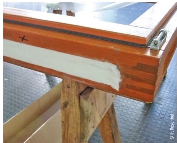
Dämmstoffeinlage im Blendrahmen
