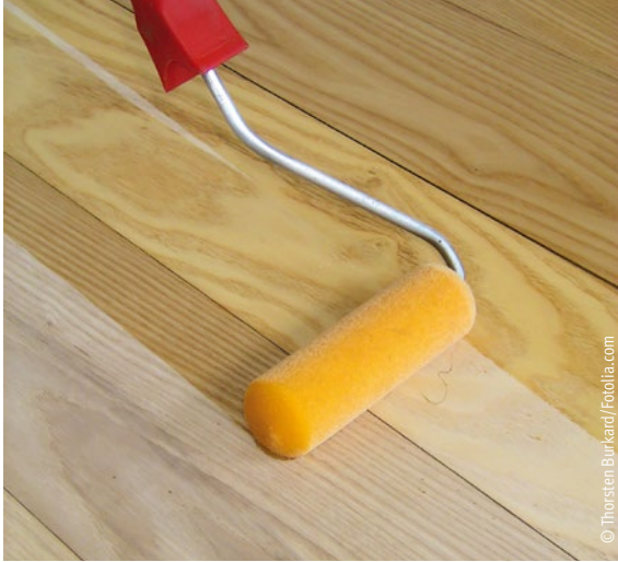
Ölen eines Holzbodens mit der Rolle
