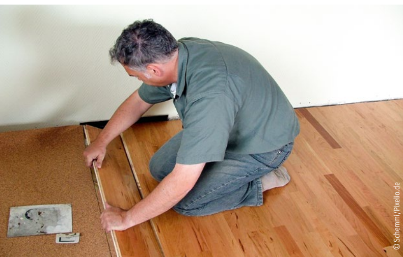
Bei der schwimmenden Verlegung wird kein Bodenkleber benötigt
