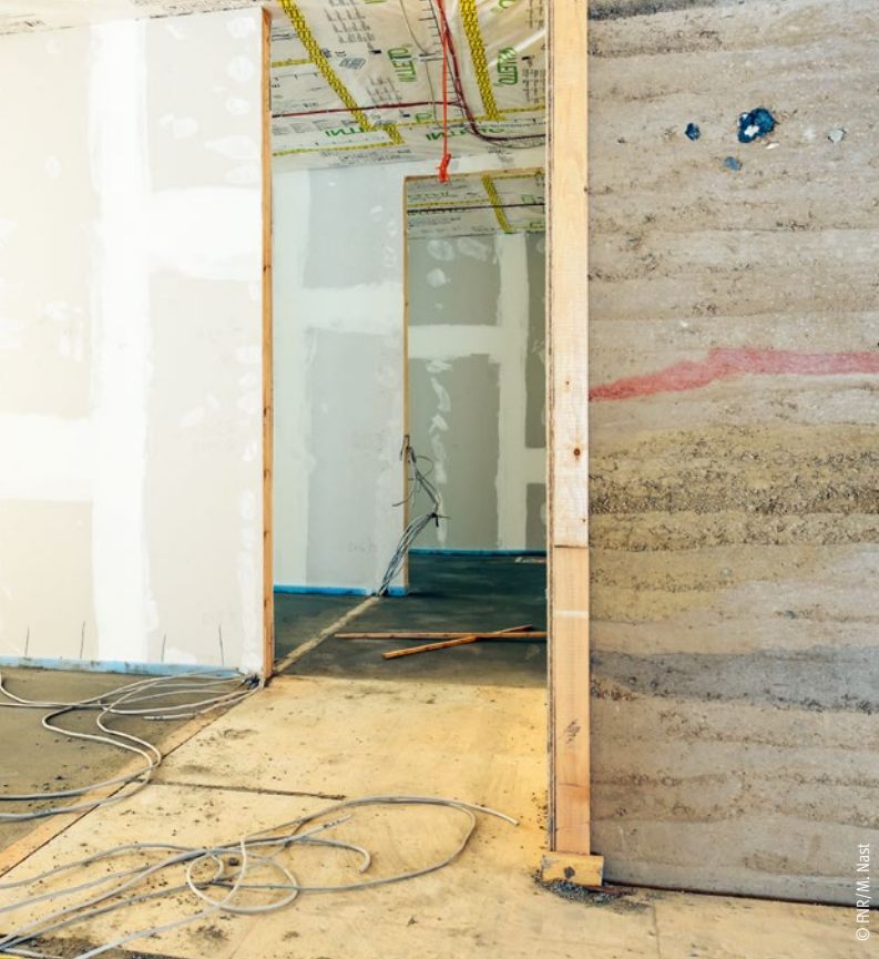
Rohbauzustand von Innenwänden
