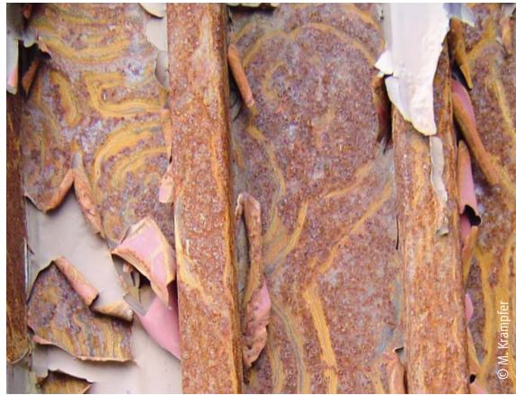
Typische Rostunterwanderung einer Lackschicht auf Eisenblech
