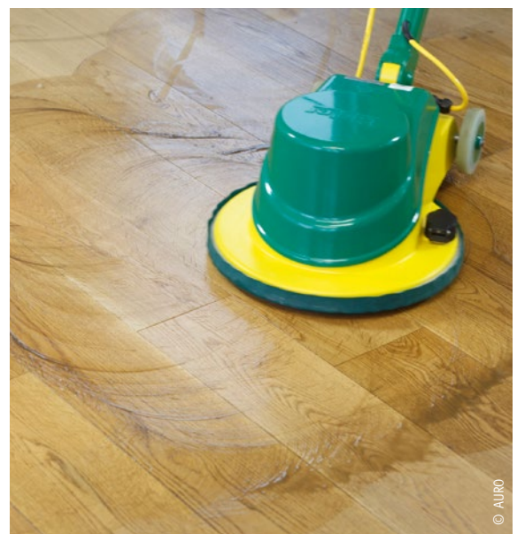
Holzoberflächen renovieren, ohne zu schleifen: Schmutz mit Reiniger und Maschine auflösen und danach abnehmen
