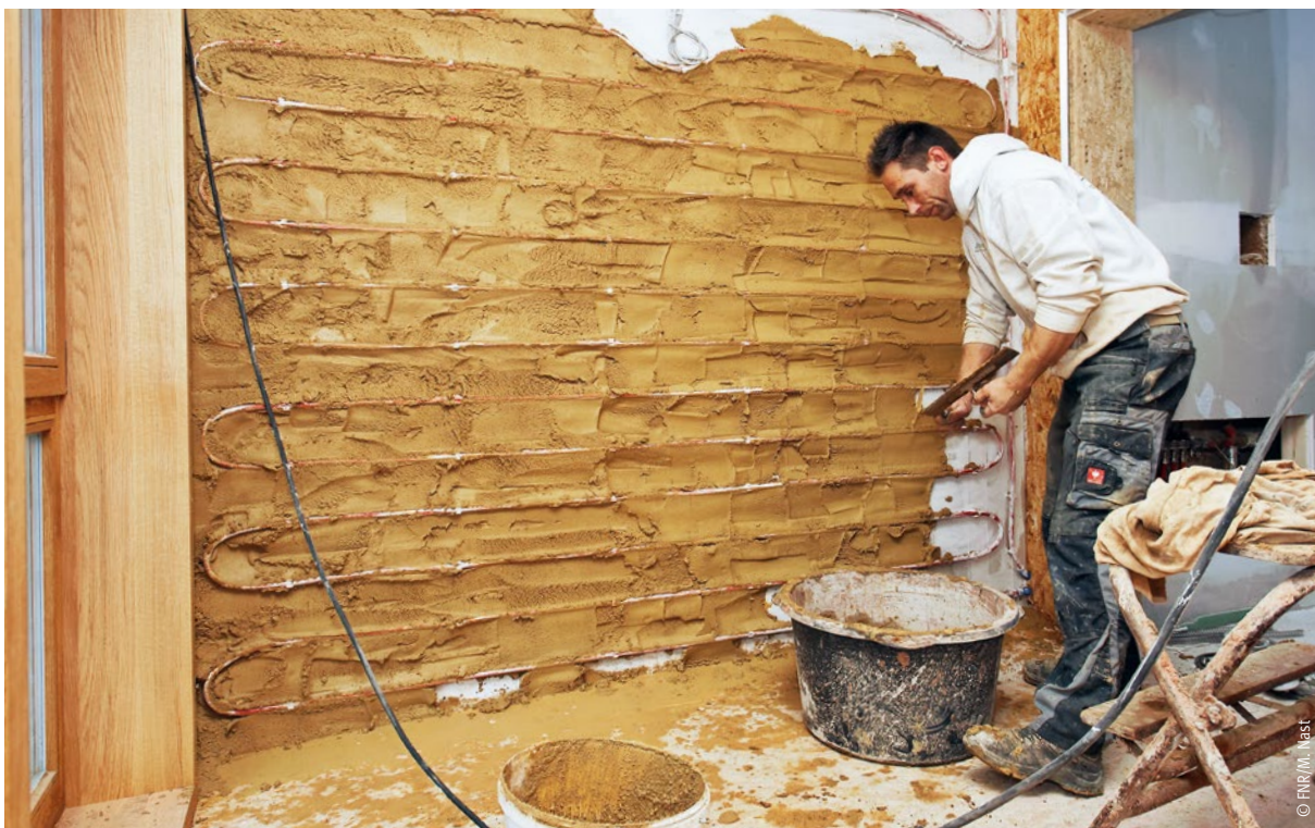
Wandheizschleifen werden mit Lehm eingeputzt
