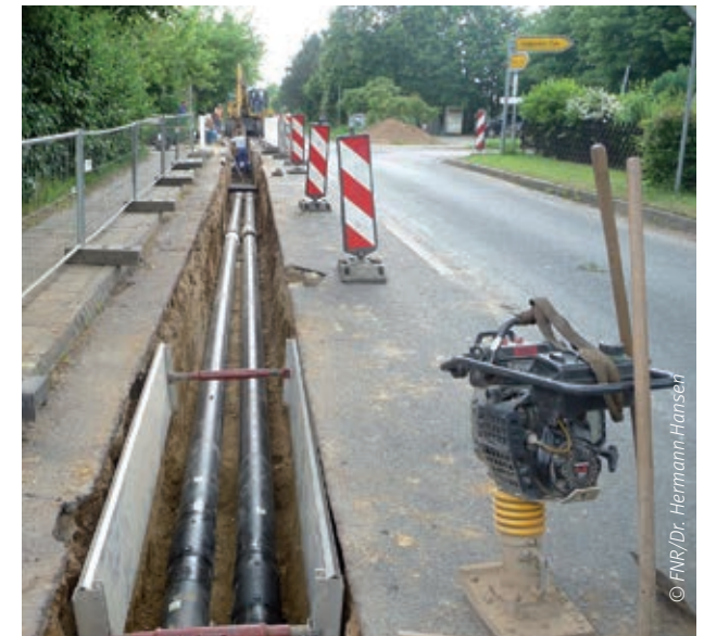
Das in Gülzow verlegte Nahwärmenetz ist einen Kilometer lang
