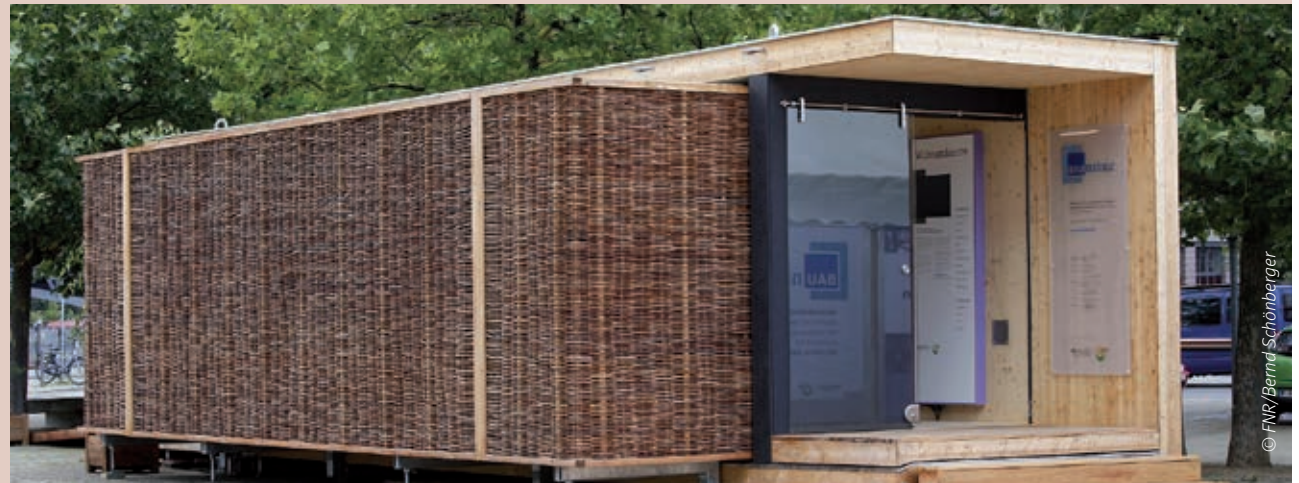
Eine zu über 90 Prozent aus nachwachsenden Rohstoffen gebaute Infobox bildet den Kern der Wanderausstellung BAUnatour
