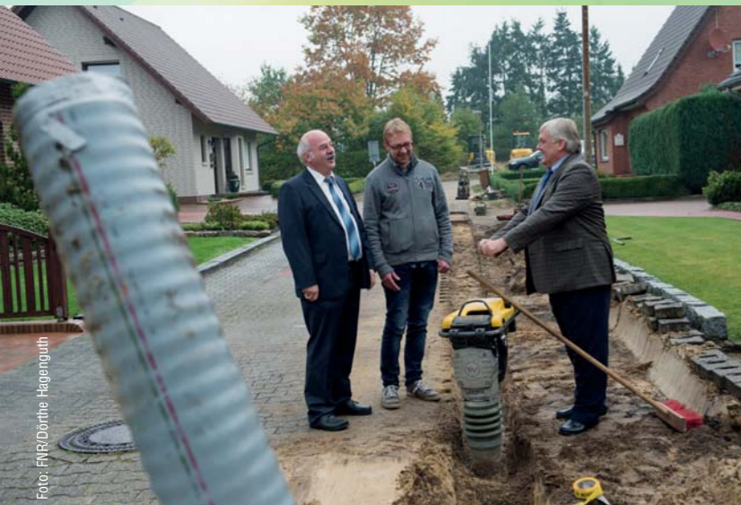
Bioenergiedorf Lathen in Niedersachsen: Die Wärmeleitung wird unter der Straße verlegt.
