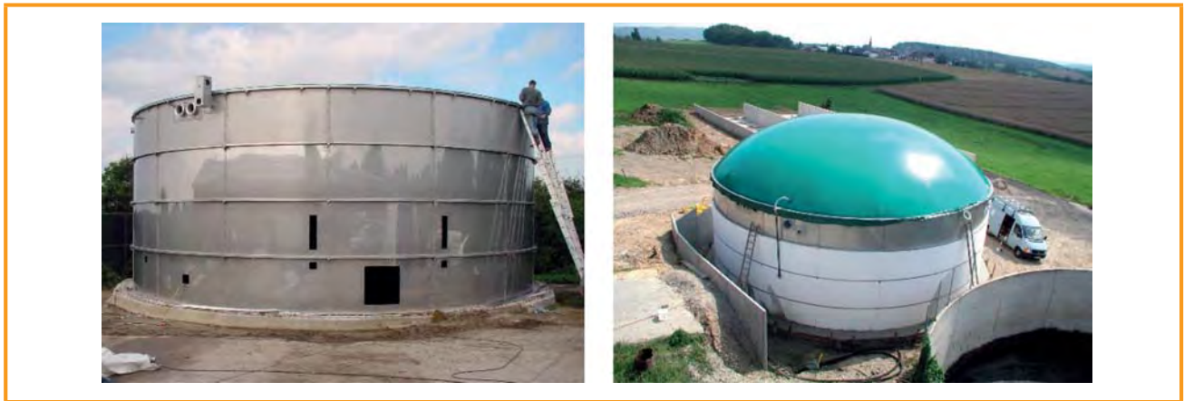
Şekil 3.30: Yapım aşamasındaki paslanmaz çelik fermentör [Anlagen- und Apparatebau Lütke GmbH]
