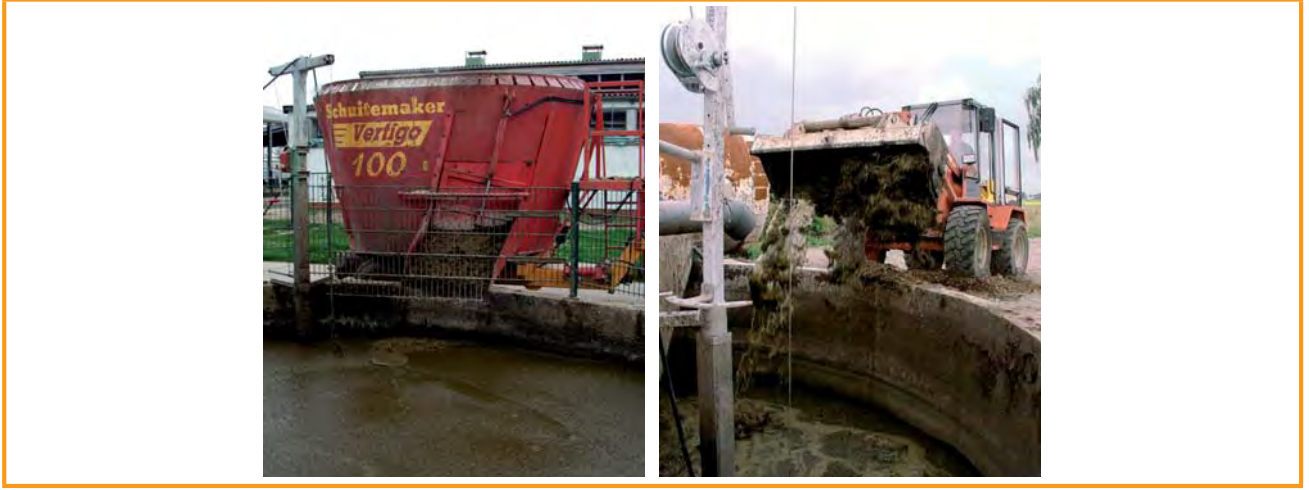
Şekil 3.14: Materyal temini esnasında ön depo veya materyal kabul deposu [Paterson, FNR; Hugo Vogelsang Maschinenbau GmbH]
