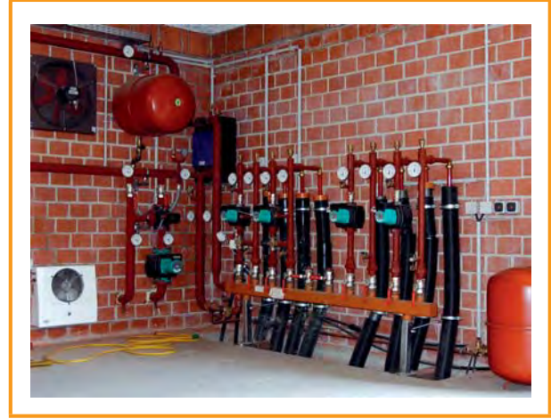
Şekil 6.7: Isı dağıtıcısı [MT-Energie-GmbH]
