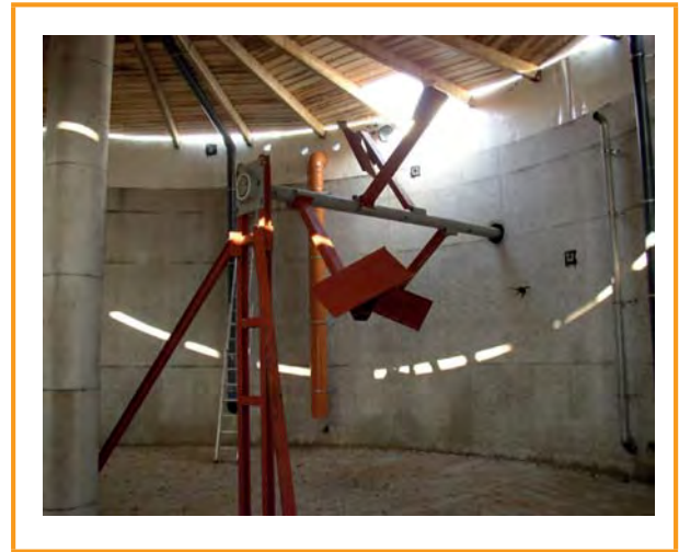
Şekil 3.34: Kanatlı karıştırıcı [PlanET GmbH]
