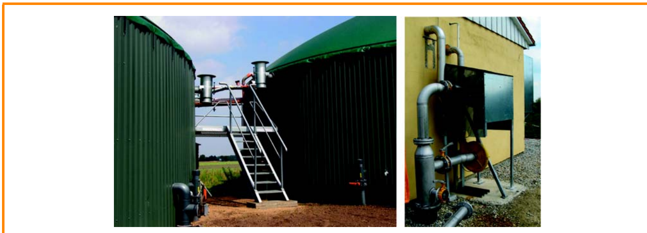
Figura 3.21: Plataforma de trabajo entre dos tanques y dispositivos de alivio de presión (izquierda); tubería de gas con compresora de soplado de aire (derecha) [MT-Energie GmbH (left), DBFZ (derecha)]
