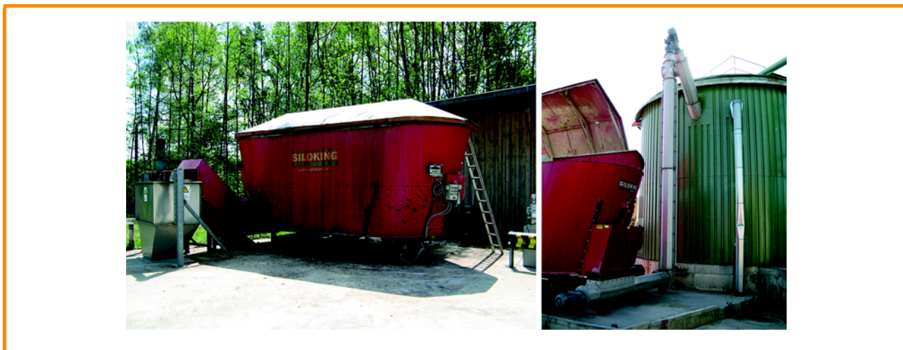
Figura 3.19: Alimentación de biomasa apilable dentro del digestor con transportadores de tornillo [DBFZ]
