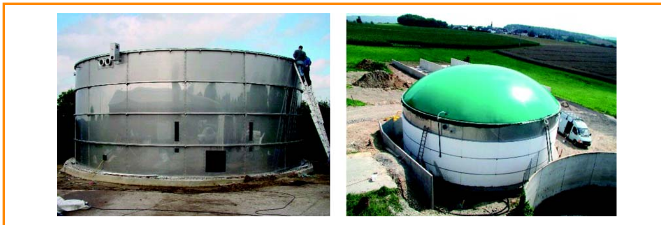
Figura 3.30: Un digester de acero especial en construcción [Anlagen- und Apparatebau Lüthe GmbH]
