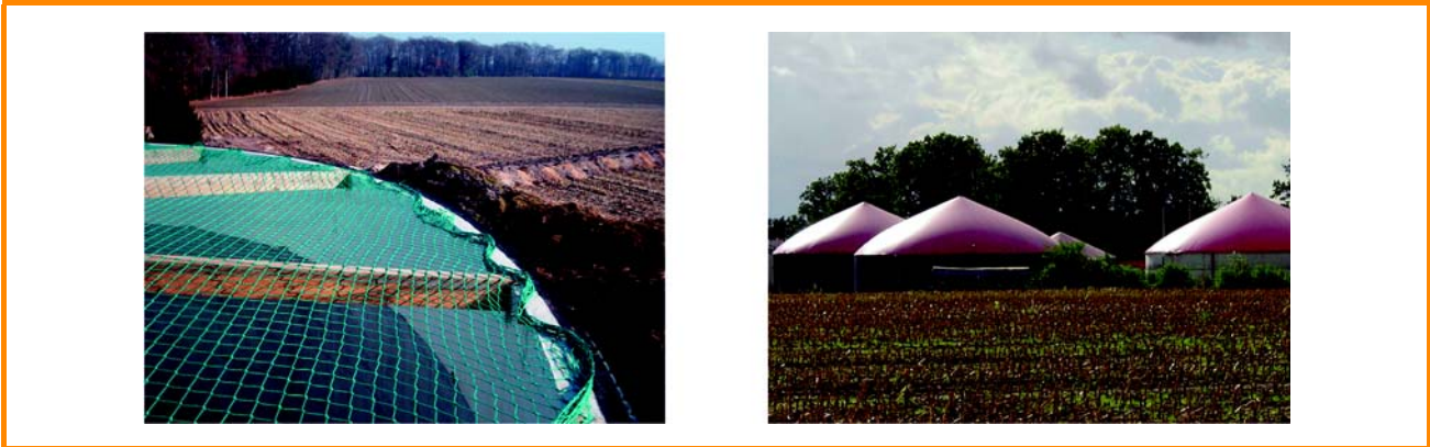
Figura 3.39: Estructura del soporte de un techo flotante (izquierda) planta de biogás con tanques de techos flotantes [MT-Energie GmbH]
