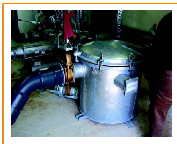
Figura 3.5: Separador en tubo para los materiales densos [DBFZ]
