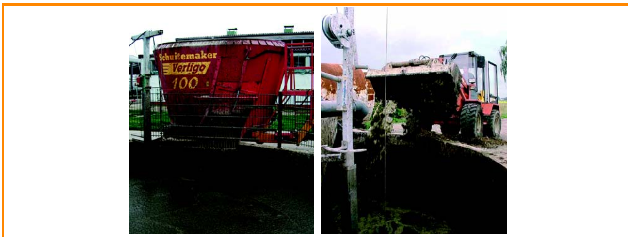
Figura 3.14: Pre-digestor o pozo de recepción en la alimentación [Paterson, FNR; Hugo Vogelsang Maschinenbau GmbH]
