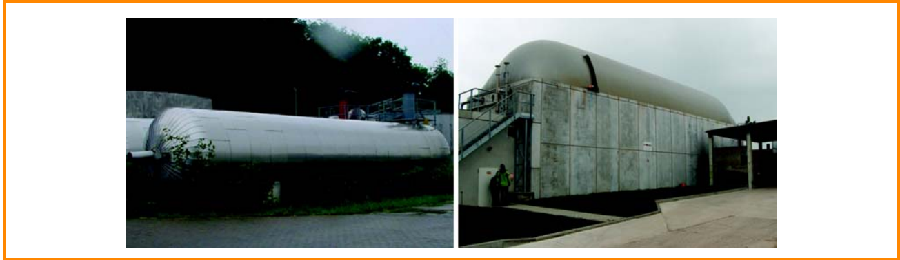
Figura 3.25: Reactores de flujo de pistón; ejemplos en campo, cilíndrico (izquierda), sección de caja, con reservorio de gas superior (derecha) [Novatech GmbH (izquierda), DBFZ (derecha)]
