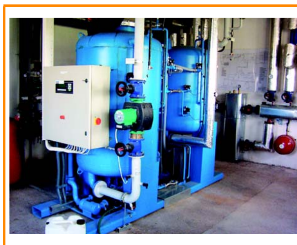
Figura 6.14: Ejemplo de un refrigerador de absorción en una planta de biogás [DBFZ]
