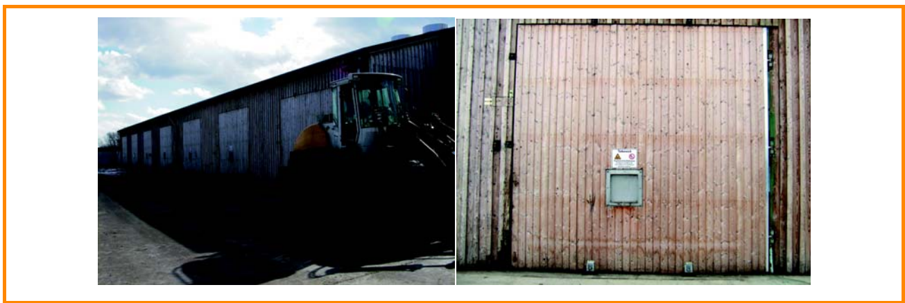
Figura 3.26: Ejemplo de digestores de caja; batería de digestores [Weiland, vTI] y puerta de digestor de caja [Paterson, FNR]
