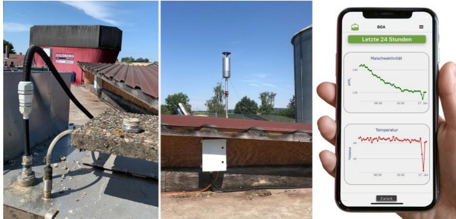
Abb. 2: Umsetzung der Messung in der Biogaspraxis mit Installation der Messsonden durch die Fermenterdecke (schwarz-grau, links im Bild; auch seitliche Einbringung durch vorhandene Öffnungen möglich) sowie Messbox (Bildmitte) mit Datenerfassung und -übermittlung zum Cloud-Speicher. Von dort können die Messwerte und ihre Verläufe am Handy abgerufen werden (rechte Abbildung).
