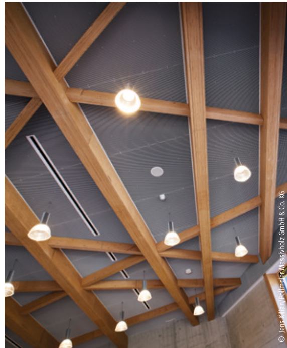
Sichtbare Balkendecke mit Baubucheträgern
