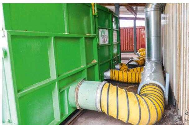
Kontejner za sušenje priključen na ventilacioni sistem
