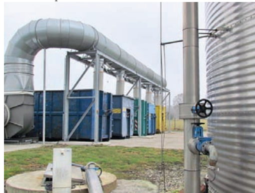
Containertrocknung der Hackschnitzel
