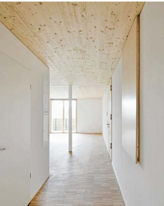
Im Innenausbau wurde Brettspertholz aus Fichte für Decken und tragende Innenwände verwendet
