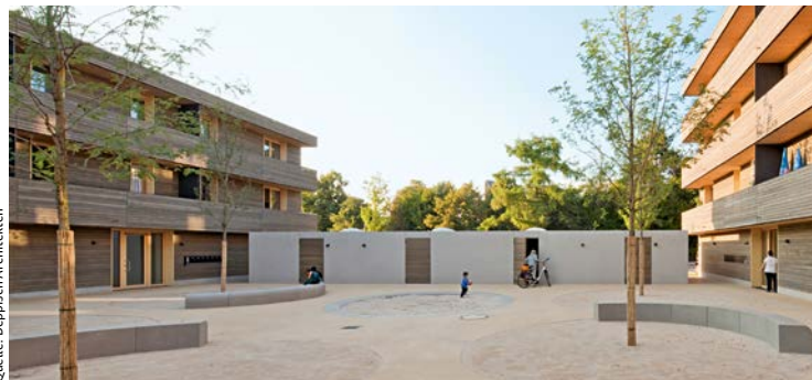
Der Hof ist Zentrum in jeder Hinsicht - und dient der Erschließung, als Treffpunkt, Spielplatz und Fläche für Feiern sowie Veranstaltungen
